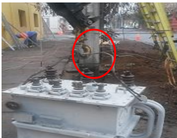
Forma correcta de realizar el estrobo.
